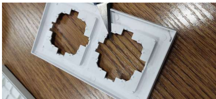
Рис. 3 (удаление выступов в месте установки розетки или узла розетки)
